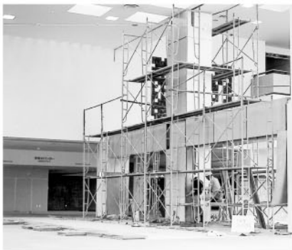
内装工事の様子
