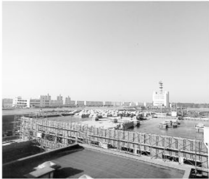
屋上から赤坂消防署方面を望む
