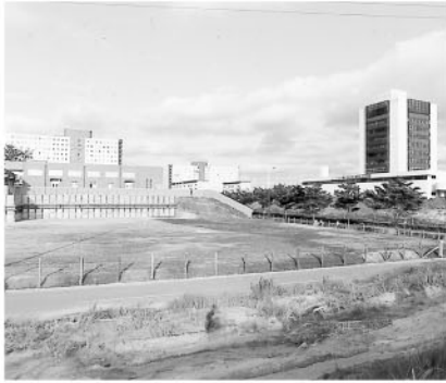
基礎工事が始まりました
